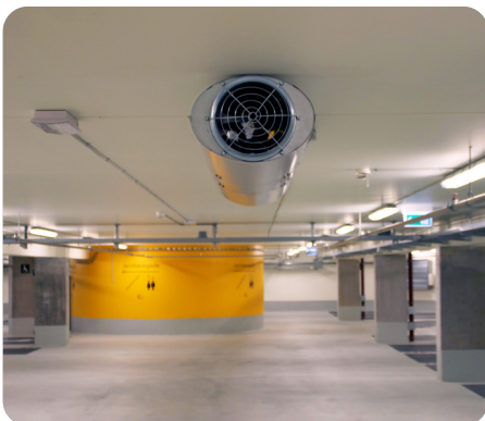
Axel Towers, København, Danmark
